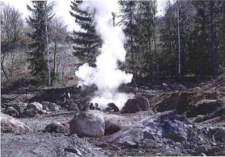
■ UUSI VASTAAN VANHA. Yläkuvassa ammutaan AutoStem I:llä 100 gramman panos ja alakuvassa vastaavan kokoinen kivi 100 gramman annoksella Senatel Powerfragia. Stem lohkaa rauhallisesti, joskin kovemmalla äänellä.
